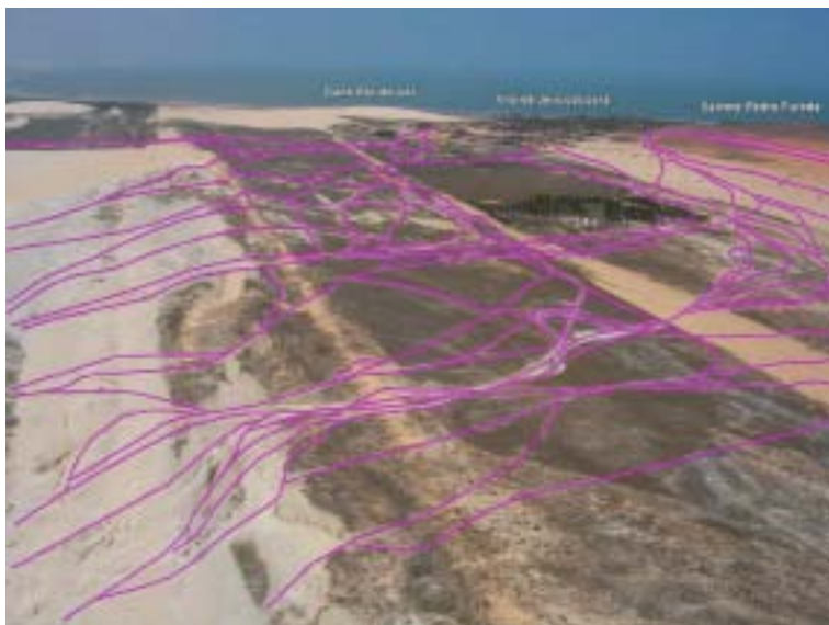
Fotografia 48 – Observou-se que o Acesso Desordenado Através da Trilha da Lagoa Grande Continua de Forma Aleatória e Desordenada até às Proximidades da Vila de Jericoacoara. Os Rastros e os Sulcos Erosivos Produzidos pelos Veículos estão Induzindo a Mobilização de Areia, Soterrando Áreas com Gramíneas e Lagoas Sazonais. Nas Proximidades da Vila, os Veículos também não Obedecem a um Eixo Definido de Acesso, Induzindo um Incremento no Transporte de Areia pelo Vento
