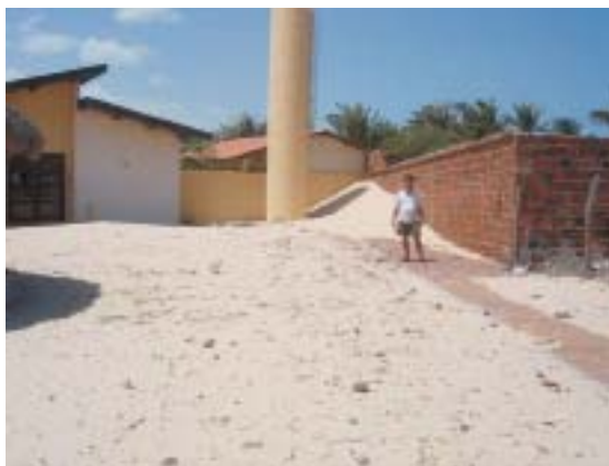
Fotografia 62 – Postos de Saúde da Vila de Jericoacoara. Verificar o Acúmulo de Sedimentos a Partir da Mobilização das Areias pelo Vento. Foram Provenientes do Setor de Acesso de Veículos Diante do Setor Oeste e das Áreas Impactadas pelas Obras de Requalificação Paisagística. Como as Areias também são Transportadas em Suspensão, Atingem as Dependências Internas do Posto de Saúde
