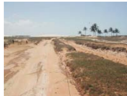
Fotografia 35 – Local de Acesso Próximo a Vila Extremamente Erodido e Atualmente Interditado
