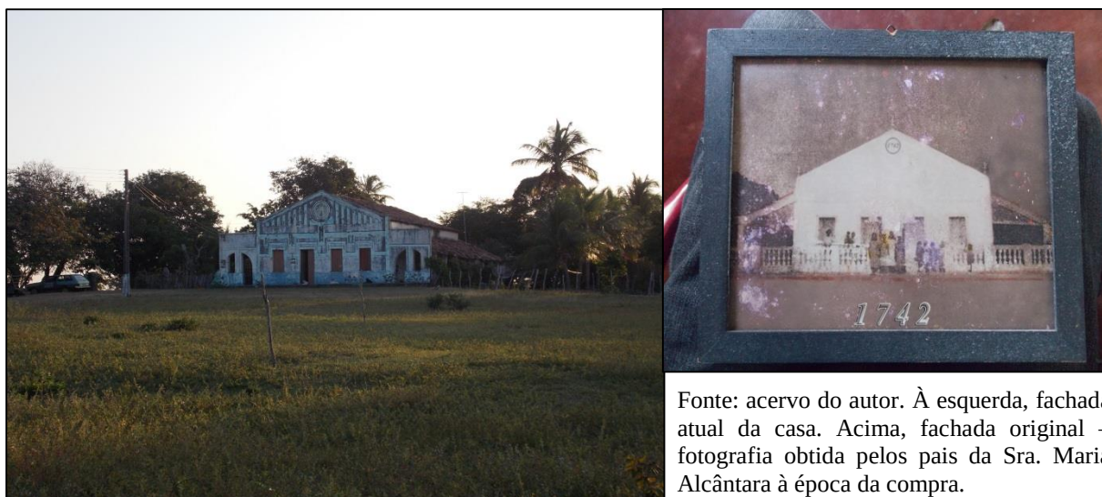
Figura 27 - Rugosidade no espaço paracuruense, casa no distrito de Jardim
