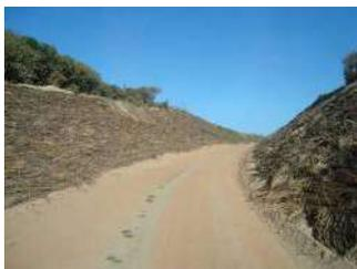
Figura 3.36 – Utilização de palhas de coqueiro para fixação das areias que se direcionam para a estrada (campo de dunas Cumbe/Canoa Quebrada).
