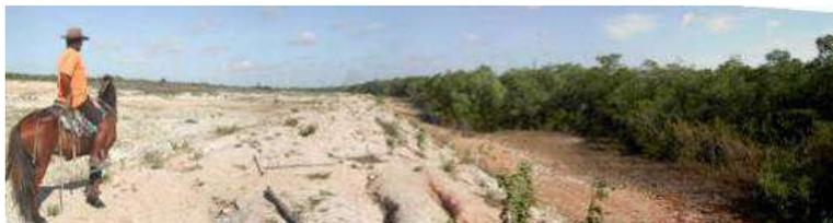
Figura 10.7 – Talude para a implantação de viveiros de camarão. Verifica-se que foi edificado em área de APP e associado ao desmatamento do manguezal e do carnaubal. Sobre os taludes, observou-se a presença de sulcos de erosão, evidenciando a não continuidade das atividades. Atualmente, encontra-se abandonado, sem nenhuma atividade de manutenção.
