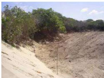
Figura 3.26 – Contato entre duna fixa desmatada (lado direito da fotografia) e aterro sobre área anteriormente vegetada para a abertura de vias de acesso sobre o campo de dunas fixas (campo de dunas da Taíba).
