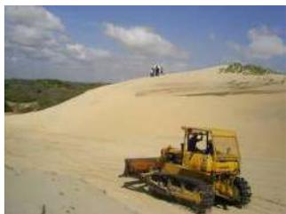
Figura 3.30 – Corte realizado em uma duna móvel. Verifica-se que a duna foi seccionada para a implantação de uma via de acesso (campo de dunas da Taiba).
