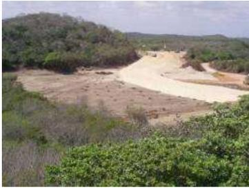
Figura 3.24 – Vista panorâmica do desmatamento de duna fixa. Base da duna fixa retira, com a remoção do solo para a instalação de vias de acesso de canteiro de obras (campo de dunas da Taíba).
