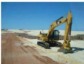
Figura 3.35 – Leito estradal compactado para acesso de guas e caminhões (campo de dunas Cumbe/Canoa Quebrada).
