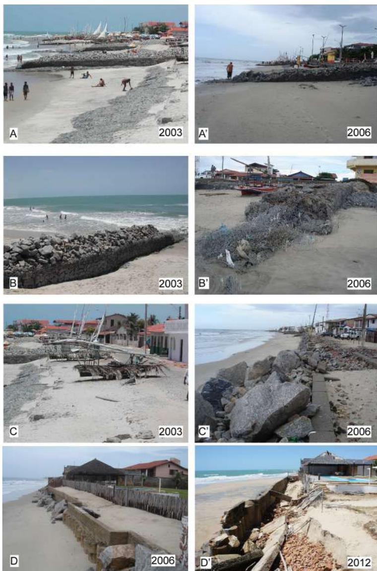
Figura 2.12 – Evolução da faixa de praia diante da vila da Caponga após a construção dos espigões e muros paralelos à faixa de praia. Verifica-se que a ação das ondas continuou a danificar os equipamentos urbanos. A evolução do processo erosivo está alcançando a faixa de praia diante das residências, pousadas e hotel.
