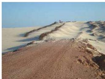
Figura 3.33 – Duna móvel soterrando via de acesso para implantação de usina eólica (campo de dunas Cumbe/Canoa Quebrada).
