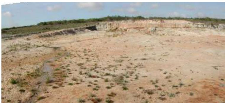
Figura 10.5 – Movimento de terra e nivelamento do terreno para a construção de viveiros de camarão. Verifica-se que, inicialmente, procedeu-se à retirada da mata ciliar e, com os tratores de esteira, alterações na topografia do terreno. No lado esquerdo da foto, verifica-se a presença de uma drenagem superficial, associada à nascente de um riacho que foi degradado. Na área desmatada e terraplenada, constatou-se ainda a presença de mais 4 nascentes degradadas (afluentes do rio Mundaú).
