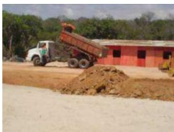
Figura 3.34 – Material arenoso introduzido no campo de dunas e sobre a via de acesso aberta para o tráfego de veículos (campo de dunas da Taíba).
