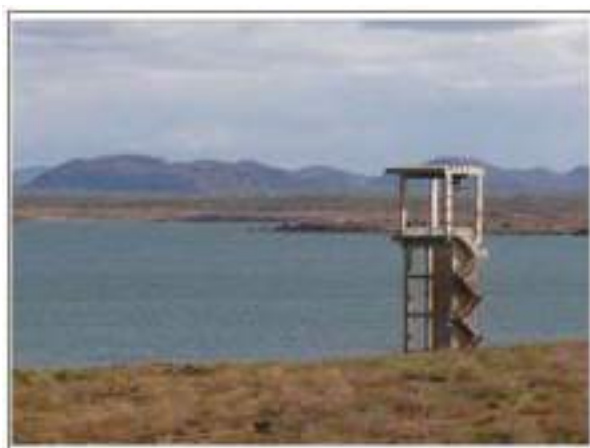
Fig. 02: Comportas da Barragem A.R.G Fonte: acervo dos autores
