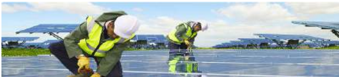
Figura 3 Capacitação de Profissional (projeto Instalador Qualificado) Fonte: ENER (2013).
