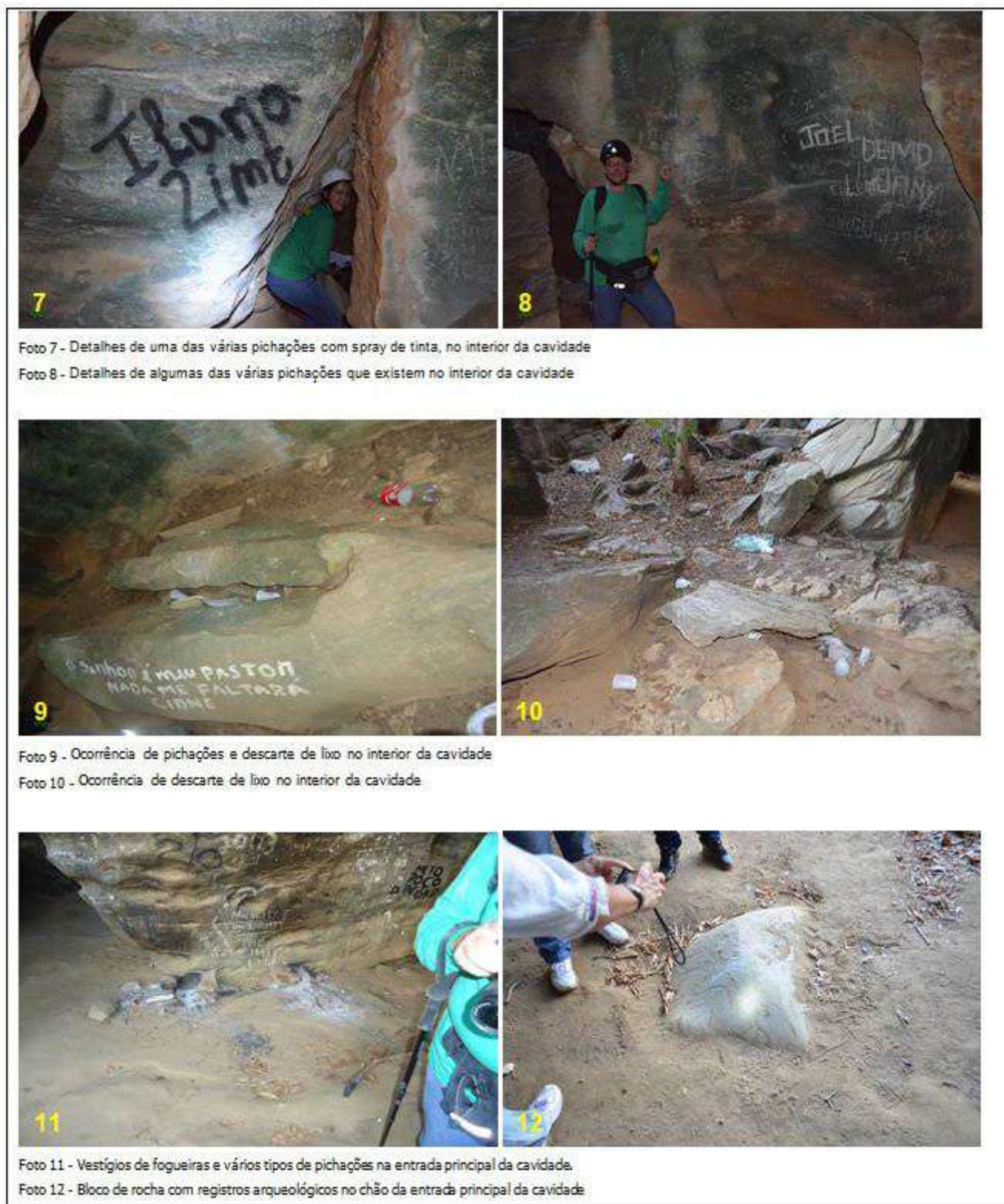
Figura 4 – Fotos da vistoria técnica do CONPAM com UFC, à Casa de Pedra em Madalena-CE.
