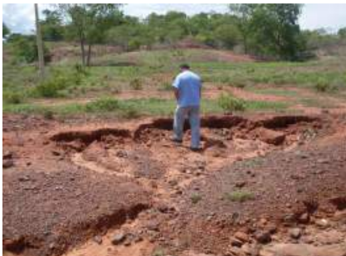
Figura 10 - Presença de ravinas na região do setor B Fonte: Santiago, 2014
