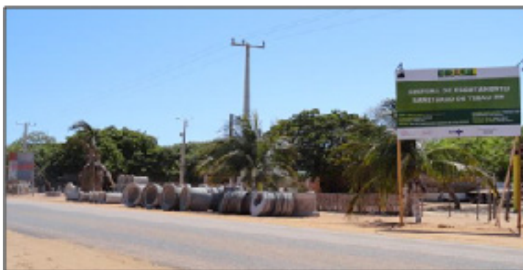
Figura 5 – Placa de indicação de obra do sistema de esgotamento sanitário de Tibau e prováveis materiais utilizáveis na obra.
