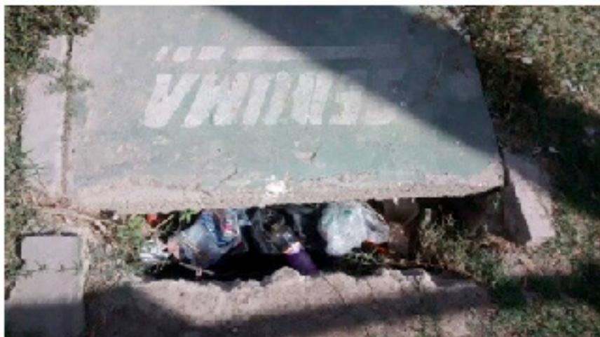
Figura 10. Mecanismos de contenção entupidos
