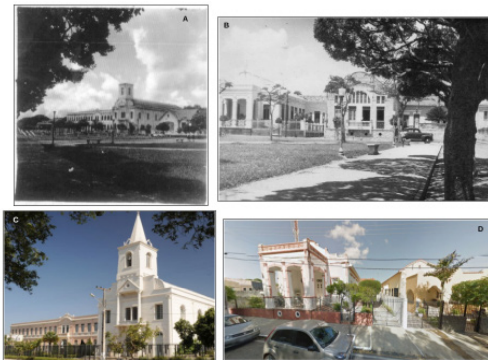
Figura 6 - A) Modificação e construção de torre sineira da igreja de Santo Antônio, em meados do século passado; B) Casas entorno no da praça Santo Antônio, início do século XX; C) Igreja Santo Antônio, ao lado colégio Nossa Senhora das Graças (CNSG), também conhecido por colégio das irmãs, em dez de 2011; D) Casas no entorno da praça Santo Antônio que sofreram poucas alterações em suas faixadas, em dez 2011. Fonte: (A e B): Brito, Moraes (2016); C) Acervo – Colégio Nossa Senhora das Graças; D) Imagens do Google Maps de dez. 2011. Org. por Oliveira (2016).
