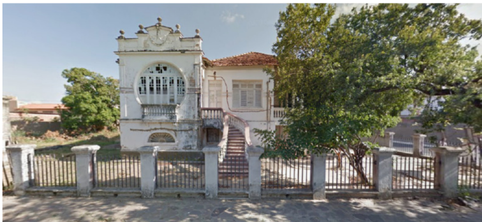
Figura 7 – Casa no entorno da praça Santo Antônio em estado de abandono.
