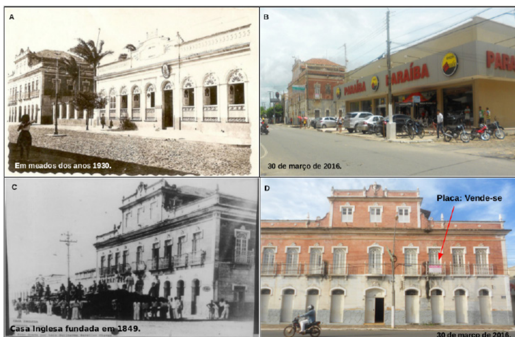
Figura 5 - A) Escritório da Booth & Company (London) Limited e Consulado Britânico e Casa Inglesa; B) Atual Loja de confecções onde funcionou o escritório da Booth & Company (London) Limited e Consulado Britânico ao lado Casa Inglesa; C) Casa Inglesa fundada em 1849 na rua Grande (Avenida Getúlio Vargas) - Foto doada por Luiz Guilherme Bacellar Chaves; D): Casa Inglesa à venda (30/03/2016).
