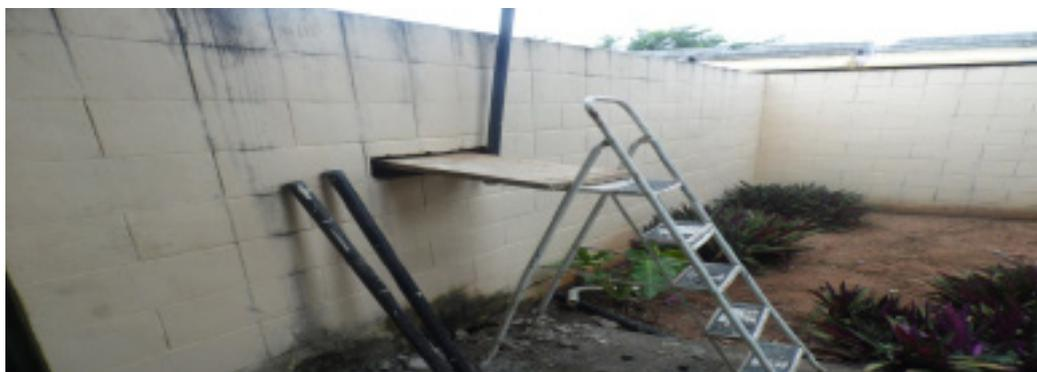
Figura 02: Preparação e fixação com cimento da plataforma de concreto para instalação do tonel.
