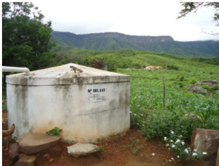
Figura 3 – Cisterna de placas no município de Frecheirinha – CE, março, 2015.
