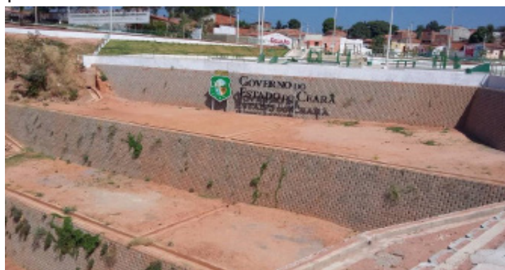
Figura –7: Obra do governo estadual do Ceará para contenção de problemas erosivos e desmoronamentos no bairro do seminário na cidade do Crato. Fonte:Arquivo pessoal, 2015.
