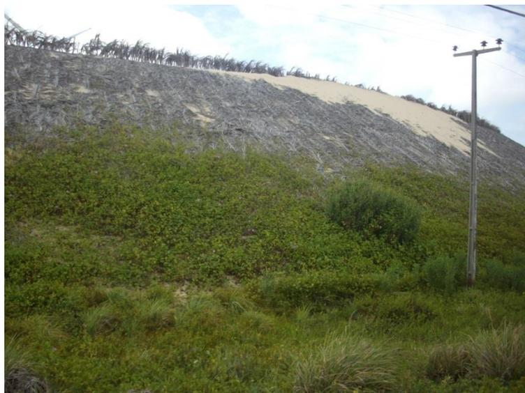
Figura 14: Fixação de dunas com palhas, para impedir a movimentação natural.
