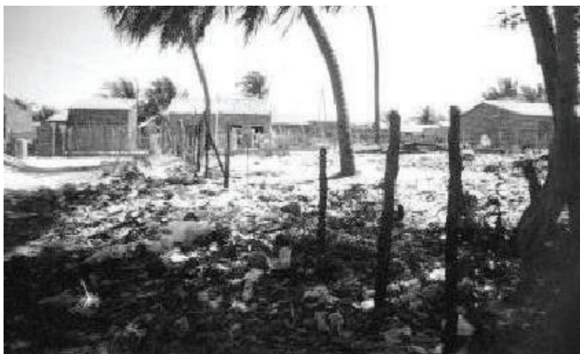
Foto 3 – Depósito de Lixo a Céu Aberto no Lagamar do Iguape
