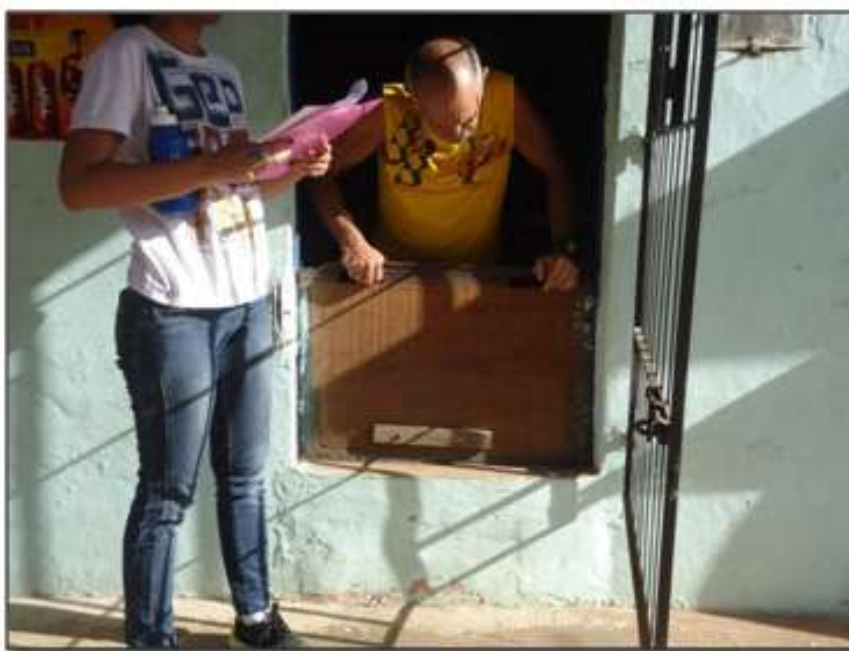
Figura 20: “Cavalete” em residência na Rua Eliezer Silva, 2014.
