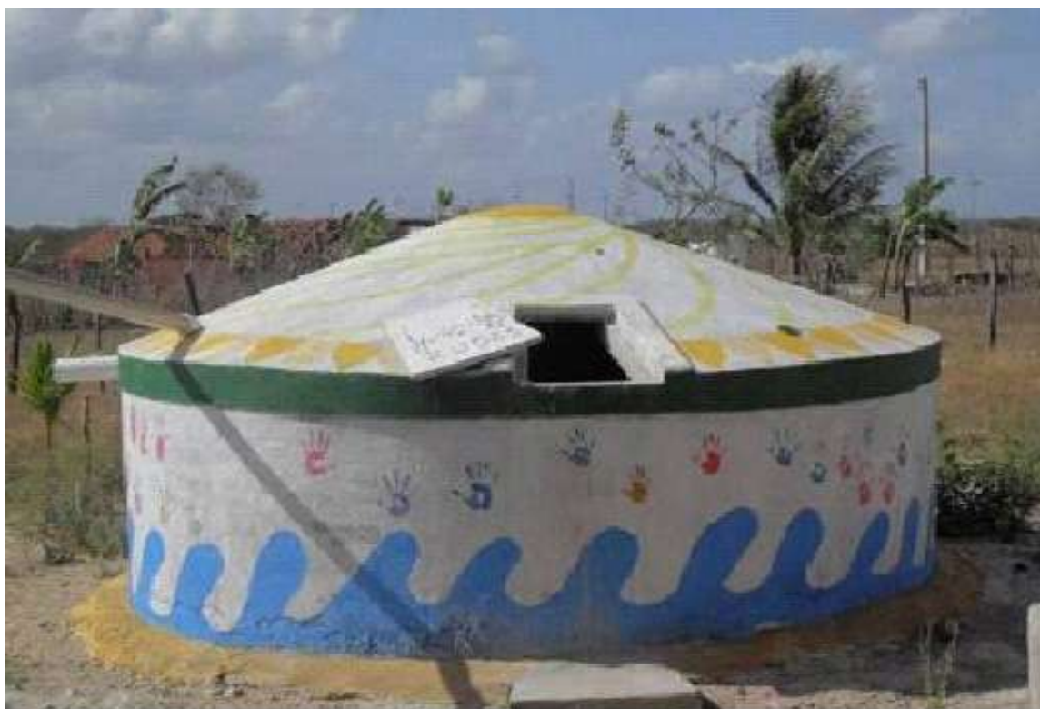
Figura 01: Cisterna da escola.
