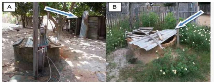
Figura 3 - Tampa inapropriada do poço M6 e situado próximo ao sanitário (A); Poço M4 Tampa inadequada, praticamente aberto.
