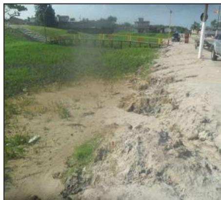
Figura – 4 Aterro da orla com uso de material arenoso. Figura – 5 Processo erosivo ocasionado no material arenoso utilizado para aterro da orla.
