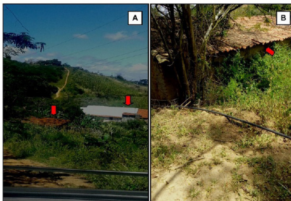
Figura 2. Construções de casas nas proximidades das nascentes (indicadas nas setas), em meio a Caatinga no sopé da serra (A,B). Povoado Serra do Poço – Poço das Trincheiras – AL. Fonte: Trabalho de campo, 2015. Organização: Nascimento, 2016.
