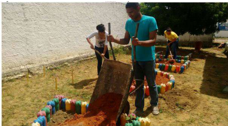
Figura 2. Construção dos canteiros. Foto de Érich Gonçalo, 2016.
