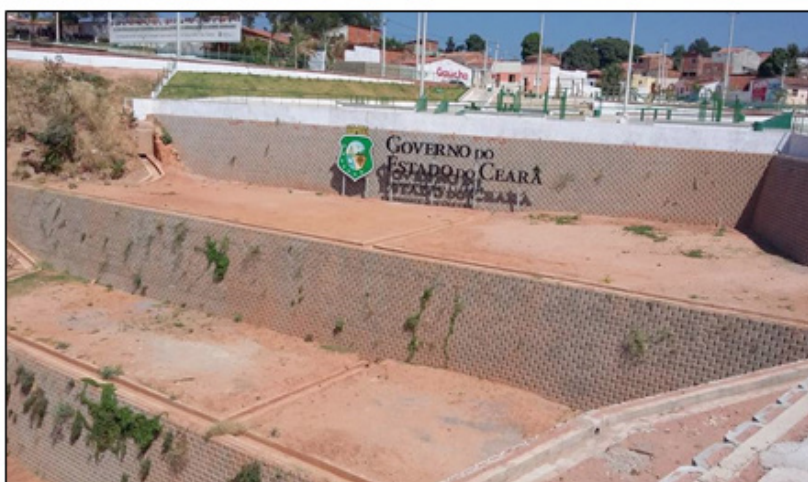
Figura –7: Obra do governo estadual do Ceará para contenção de problemas erosivos e desmoronamentos no bairro do seminário na cidade do Crato.
